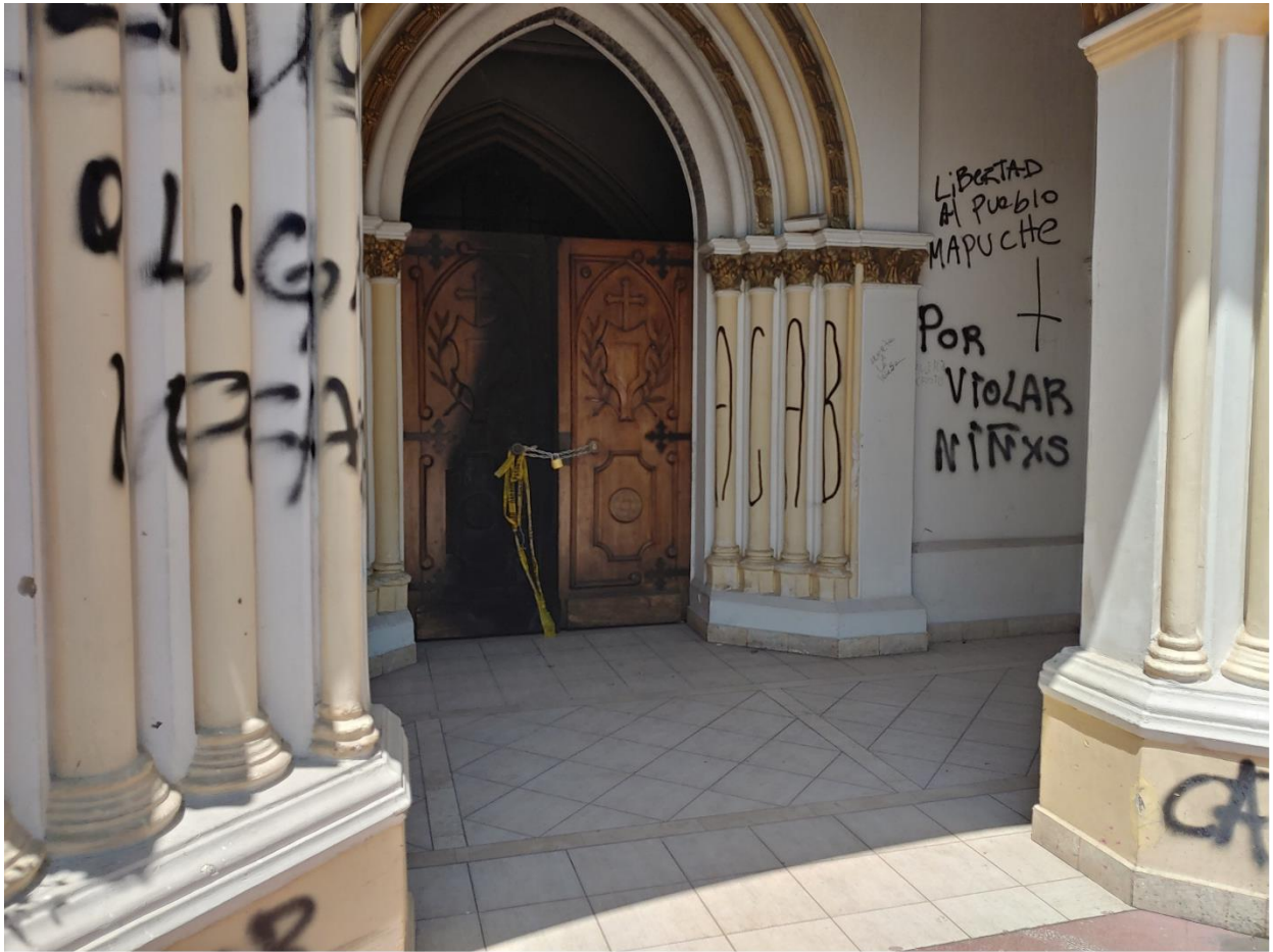
Iglesia San Borja, Near Avenida Libertador Bernardo O'Higgins, Santiago
